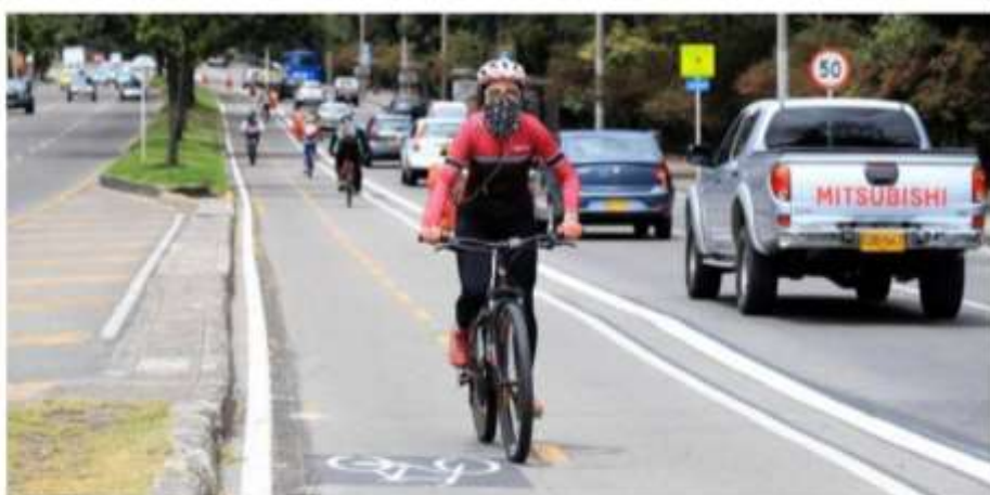
El bicarril de la carrera séptima (foto) tiene una extensión de 17,7 kilómetros y va desde la calle 22 sur hasta la 196. Foto: César Melgarejo
